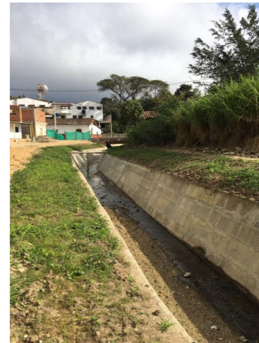
Canalización Quebrada La Loma - González
